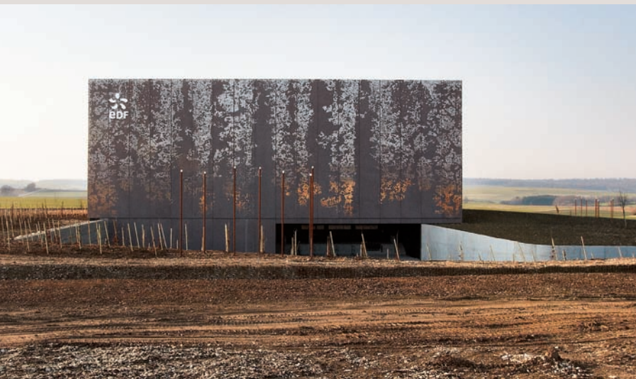
→ Archives EDF à Bure, agence Lan architectes. Photo : © Julien Lanoo.
