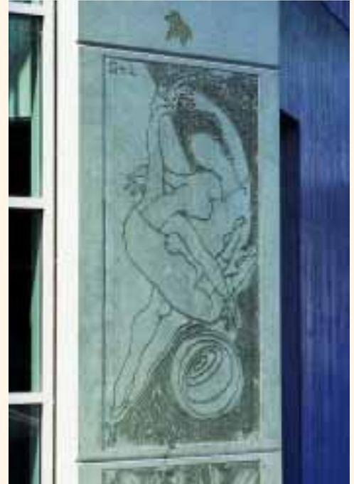
gravée sert à créer des films qui sont positionnés à plat en fond de banc de coffrage. Le motif présent sur les films est imprimé avec une encre désactivante qui va enlever la première couche de laitance du béton et faire apparaître les granulats plus sombres. La finesse de cette technique permet une variation d'intensité de l'impression et donc différentes nuances, que l'on retrouve au travers des
